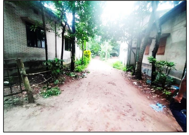
Drain-6, Kaliganj Pourashava
