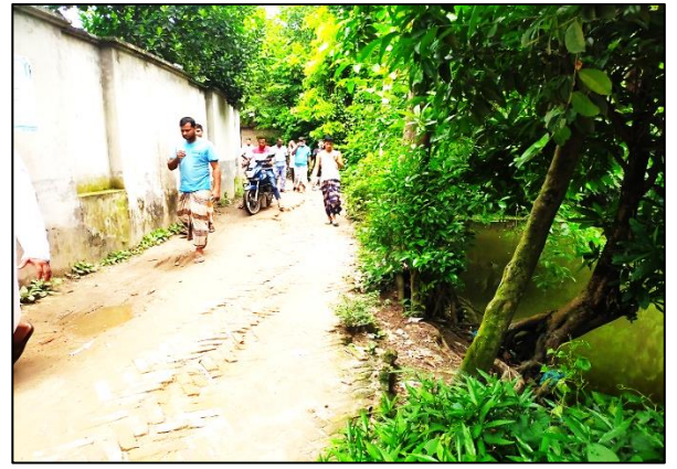
Drain-7 Kaliganj Pourashava
