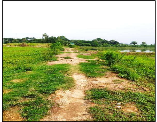
Road-3, Kaliganj Pourashava
