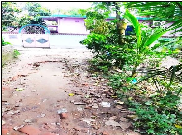
Road-7, Kaliganj Pourashava
