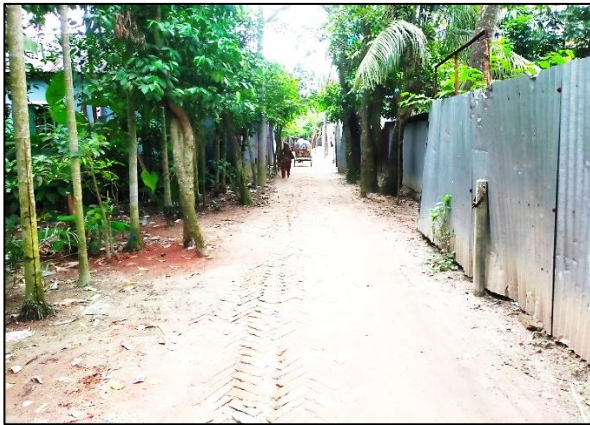
Drain-7 Kaliganj Pourashava
