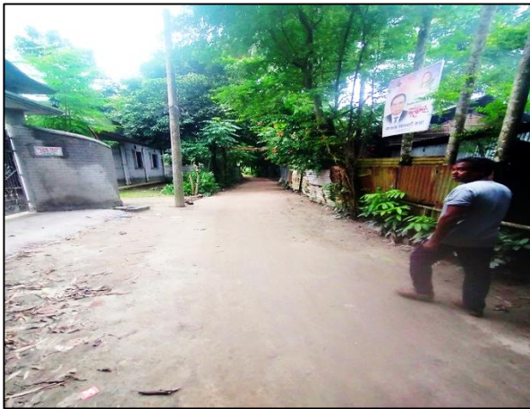
Road-6, Kaliganj Pourashava
